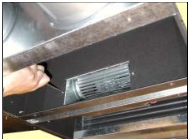
Fig. 5-7 Fan removal
